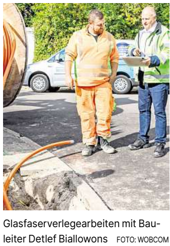
Glasfaserverlegearbeiten mit Bauleiter Detlef Biallowons FOTO: WOB COM
