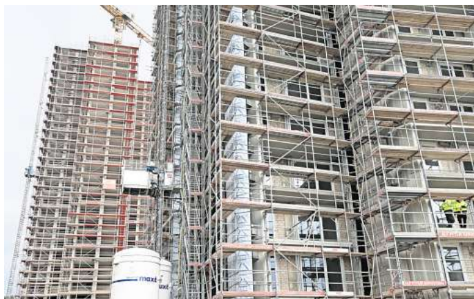
Sanierung an Don Camillo und Peppone: Die Alu-Fassade am kleineren Hochhaus wird schon angebracht. FOTO: BRITTA SCHULZE
