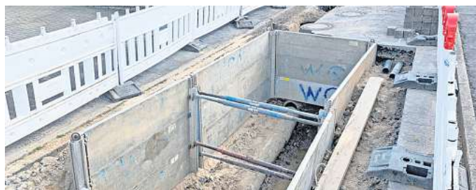
Auf einer Fläche von rund fünf mal drei Metern ist der mögliche Tagesbruch freigelegt und gesichert worden. FOTO: EIKE BRUNS/LBEG
