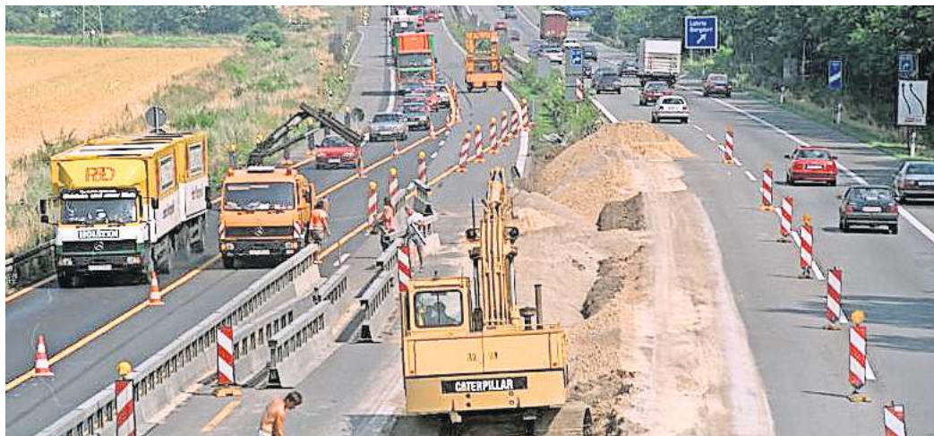
In den 1990er-Jahren wurde die A2 auf drei Fahrspuren ausgebaut. Das Bild zeigt die Baustelle in Höhe der Anschlussstelle Lehrte.
