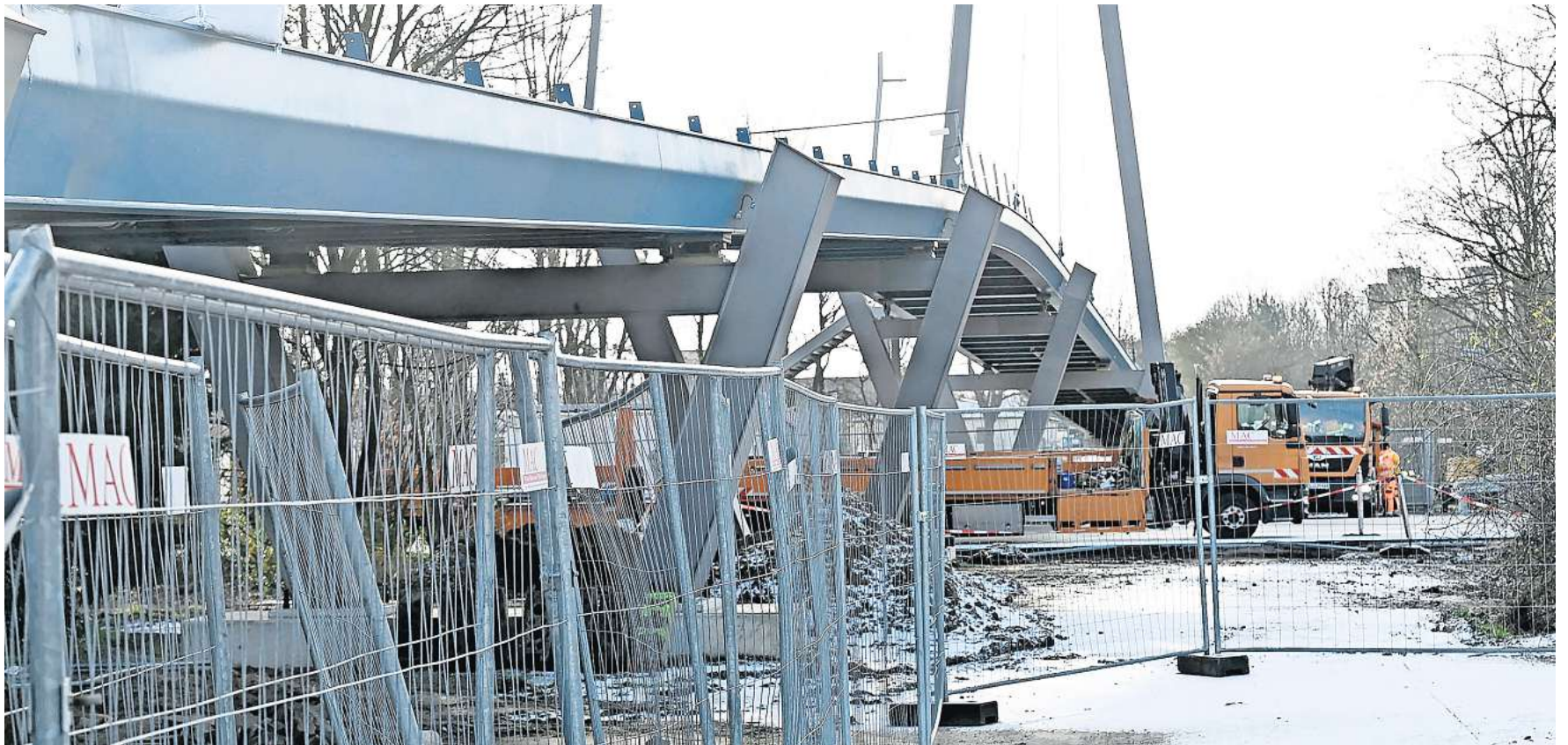
Überbau, Pylon, Seilabhängung und Lager der Hertha-Peters-Brücke sind fertig, jetzt sollen die Restarbeiten folgen, wenn das Wetter mitspielt.
