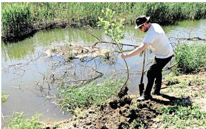
Einige Bäume konnte Sören Brose direkt an den Böschungsfuß setzen. Dort gelangen die Wurzeln auch im Sommer schnell ans Wasser und halten die Böschung fest. FOTO: PR
