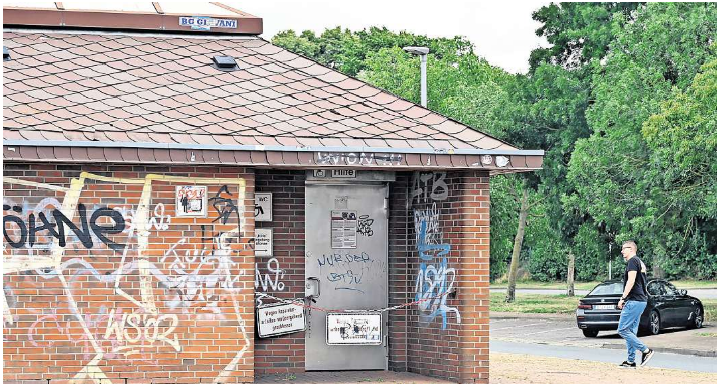
Schilder und ein Vorhängeschloss weisen darauf hin: Das Toilettenhäuschen auf dem Rastplatz Röhre-Süd ist immer noch gesperrt.
