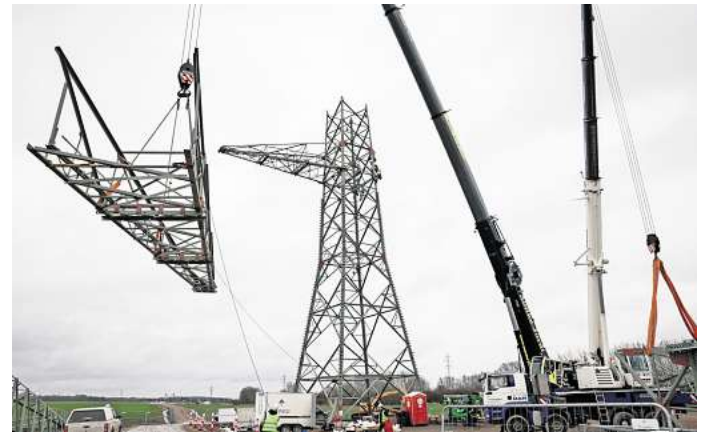
Mitarbeiter einer Spezialfirma montieren einen Strommast für die 380-kV-Ostküstenleitung für Tennet.
