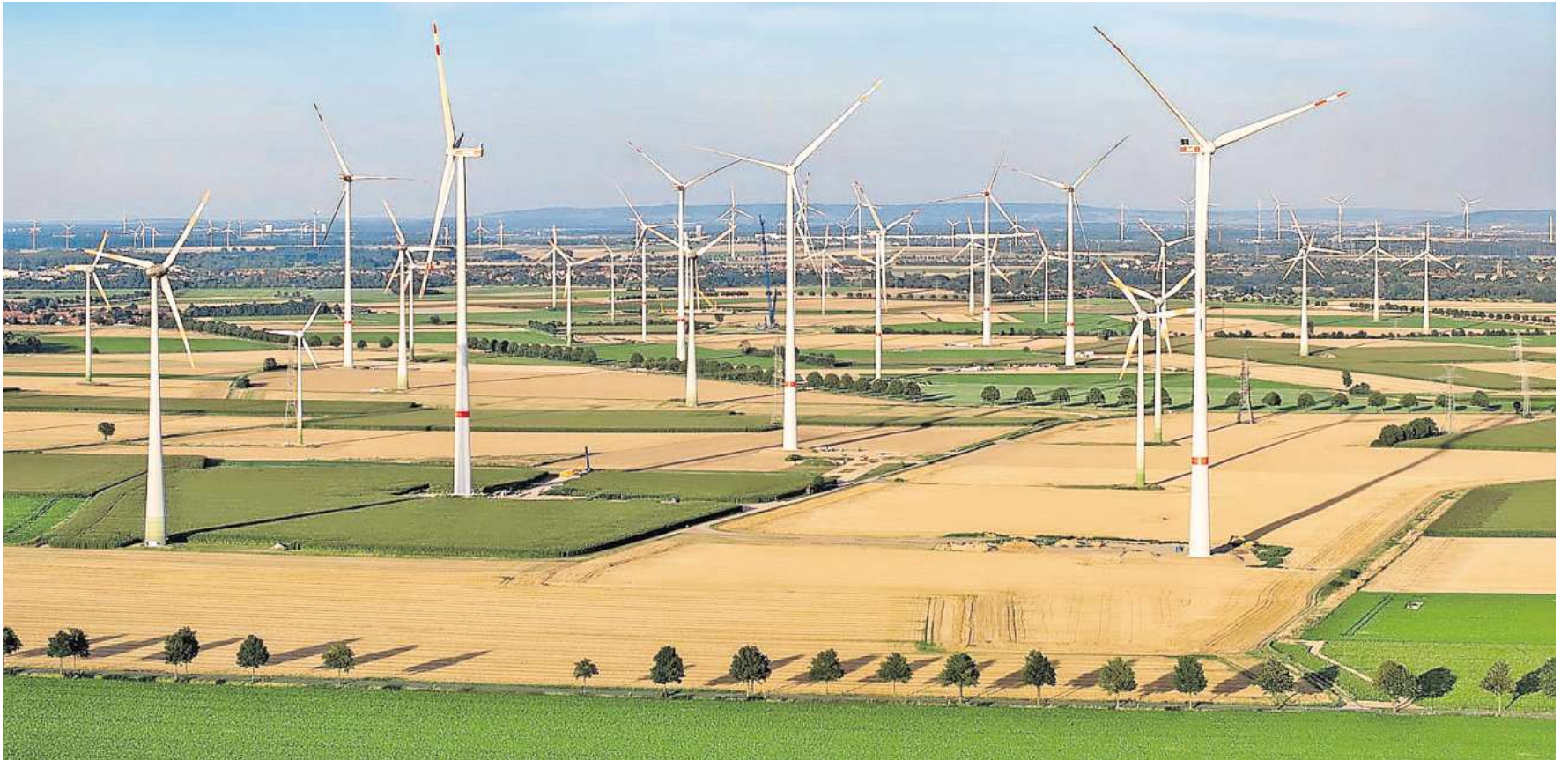
Klimafreundliche Energie: Einer der größten Windparks weit und breit ist nicht weit weg von Hohenhameln. Die Turbinen bei Lesse und Barbecke haben eine Gesamtleistung von 61,8 Megawatt.
