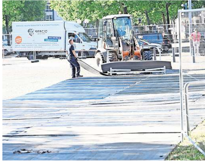
Gesperrt: Die Bauarbeiten auf dem Schützenplatz laufen.
