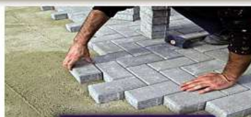
Pflasterverlegung
