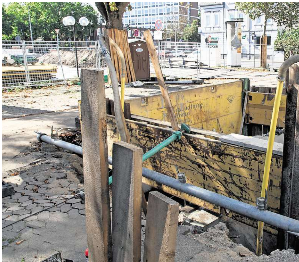
Hinter der Verschalung versteckt sich das Herzstück des neuen Regenwasserablaufs am Schützenplatz.
