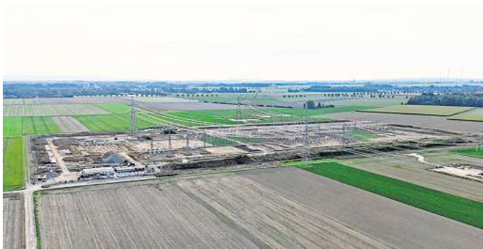
Das Umspannwerk in Liedingen wird gebaut.
