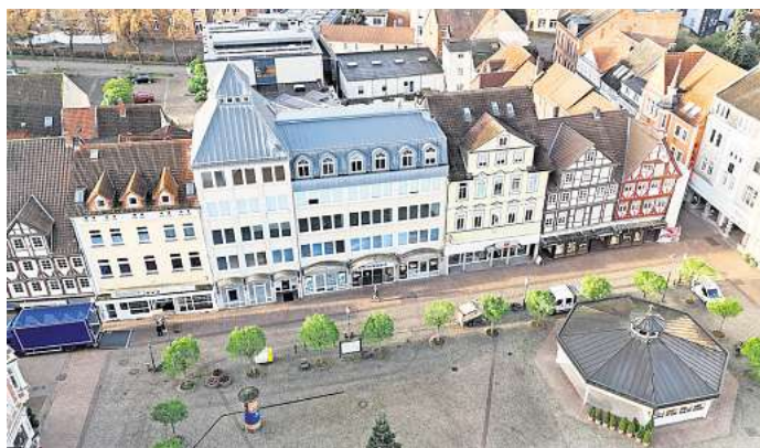
Das alte Volksbank-Gebäude (3. von links) am historischen Marktplatz soll abgerissen werden. FOTO: RALF BÜCHLER
