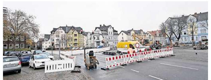
Gesperrt: Nichts geht mehr auf der Richard-Langeheine-Straße am Peiner Schützenplatz. FOTO: RALF BÜCHLER
