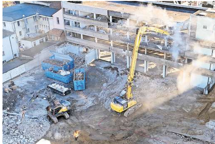
Die Luftaufnahme zeigt den großen Bagger mit seinem XXL-Arm. Mit der Abbruch-Zange „knabbert“ die Maschine am alten Postgebäude.
