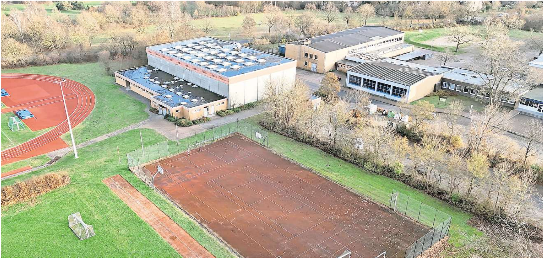
Ein Blick von oben auf die stark sanierungsbedürftige Kreissporthalle in Edemissen (oben links). Auf der Fläche mit dem Tartan-Feld (vorne) könnte ein moderner Ersatz-Neubau entstehen.
