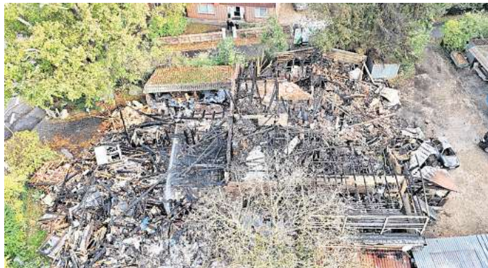
Nach dem Großbrand in Blumenhagen: Das liebevoll renovierten Fachwerkhaus wurde zur verkohlten Ruine. FOTO: RALF BÜCHLER
