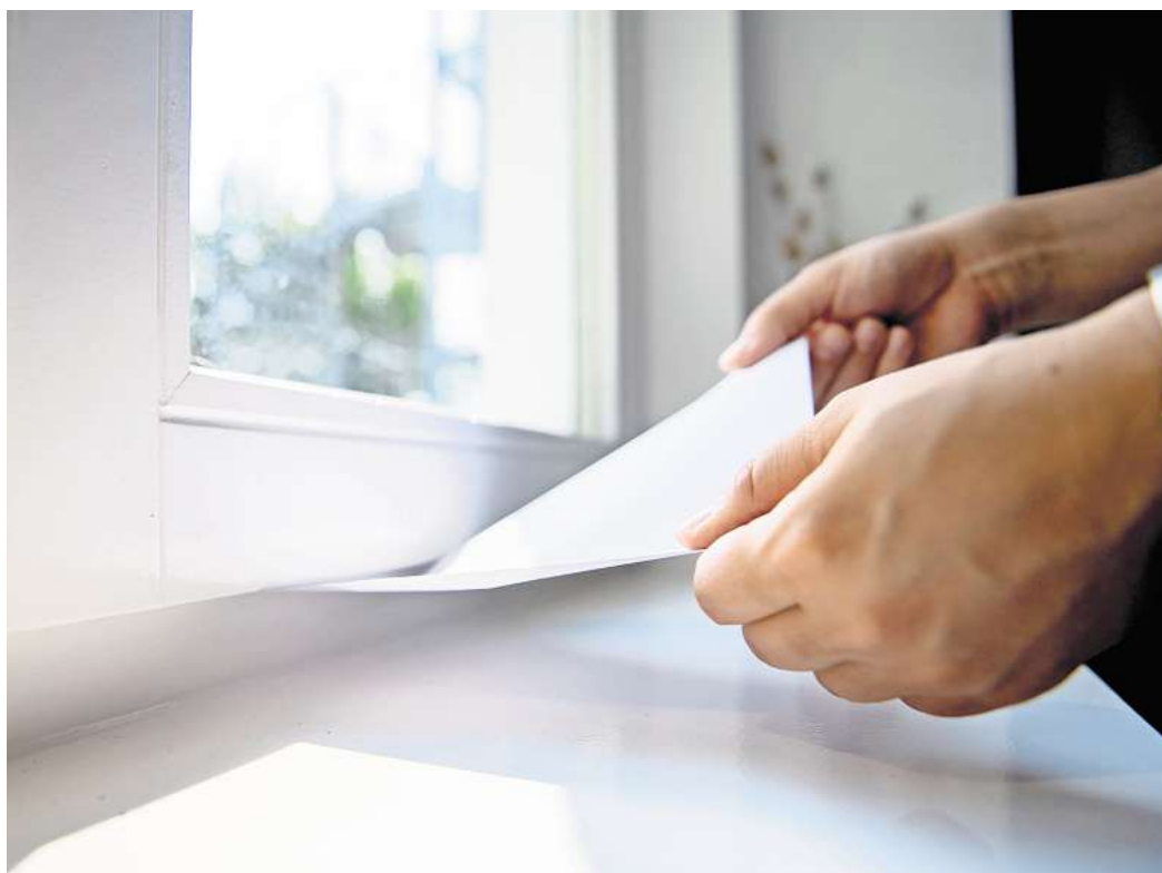
Wer das eingeklemmte Blatt Papier herausziehen kann, muss sich die Dichtungen genauer anschauen und diese vermutlich austauschen. Foto: Zacharie Scheurer/dpa-mag
