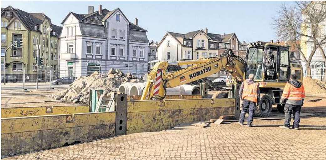
Der Peiner Schützenplatz ist seit dem vergangenen August eine Baustelle. In Kürze sollen die Bauarbeiten erfolgreich beendet werden.
