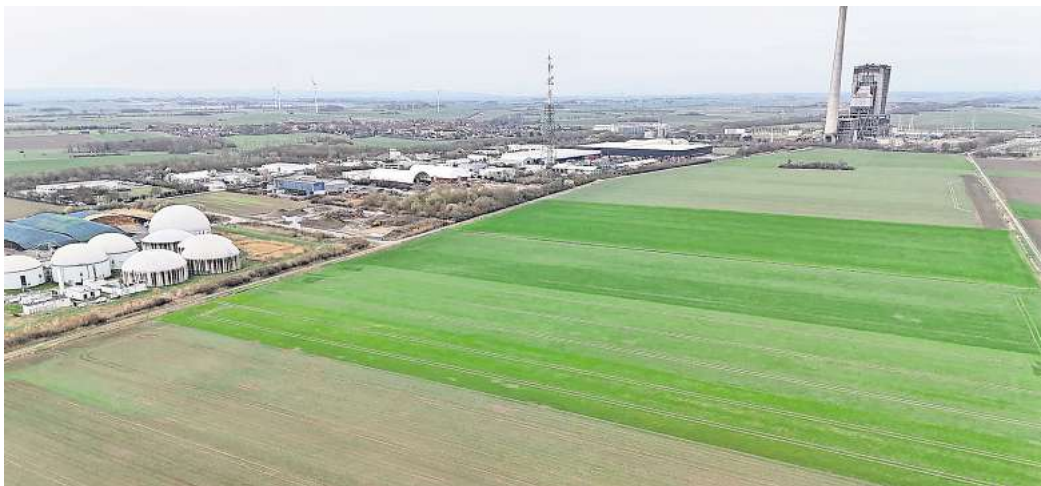
Die Planungen laufen: Auf dieser Fläche im Gewerbegebiet „Ackerköpfe“ soll die Serverfarm entstehen. FOTO: RALF BÜCHLER
