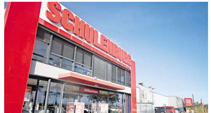
Das Möbelhaus in Gadenstedt soll umfassend modernisiert werden. FOTO: MÖBEL SCHULENBURG
