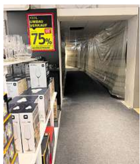
„Staubschutzfolie“: Während der Umbauarbeiten sind einzelne Zonen mit Staubschutzfolie verkleidet, der Verkauf läuft parallel weiter und hält viele Rabatte bereit.
