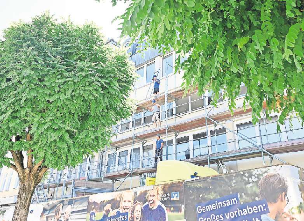
Außenabriss gestartet: Am Peiner Marktplatz errichteten Bauarbeiter zunächst das Gerüst für die Volksbank-Hauptstelle.
