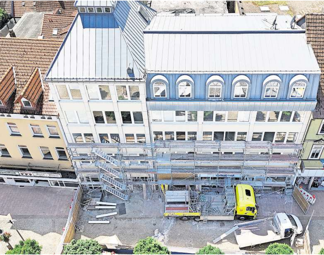
Perspektive von oben: Mit dem Außenabriss der ehemaligen Volksbank-Brawo-Hauptstelle geht es in die nächste Bauphase des Neubauprojekts.
