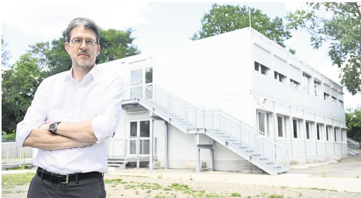
Die mobilen Klassenräume konnten nicht freigegeben werden, da es Probleme mit den Fundamenten gegeben habe, sagt Malte Holthusen, Leiter des Gymnasiums in Groß Ilsede. Foto: Ralf Büchler
