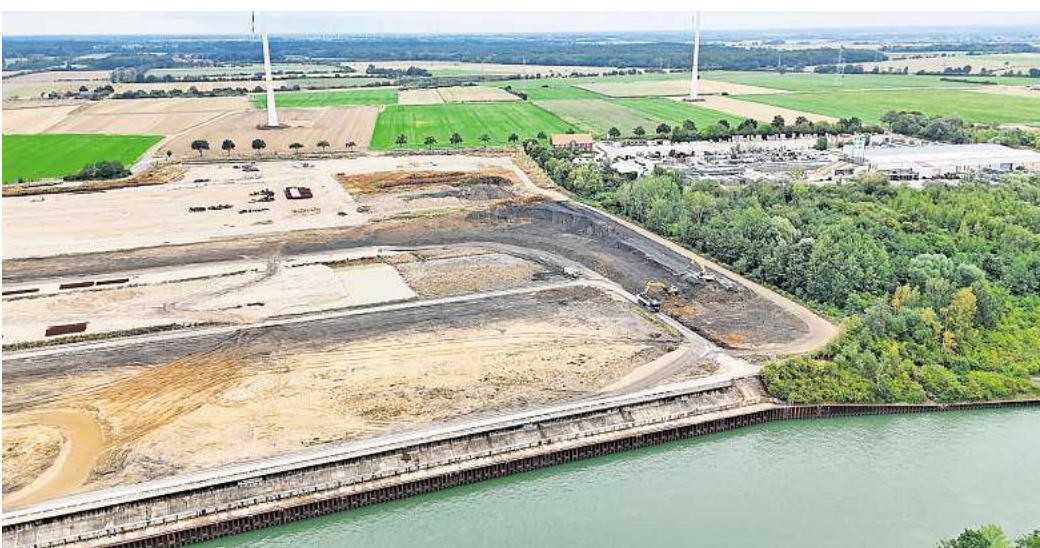
Das Gelände am Mittellandkanal Mehrum, auf dem die Pommefabrik entstehen soll: Das Abtragen des kontaminierten Erdwalls läuft weiter. Foto: Ralf Bächler
