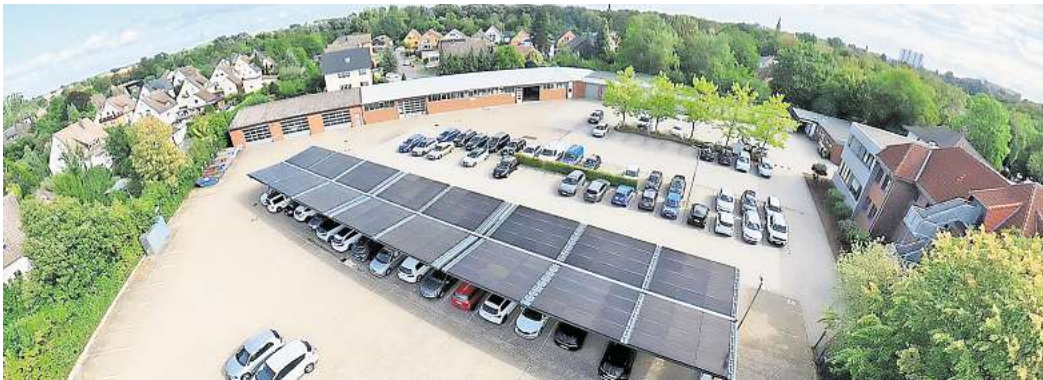
Die neue PV-Anlage auf dem Betriebshof des Dienstleisters soll bis zu 230.000 Kilowattstunden Strom im Jahr liefern. Foto: Wasserverband Peine
