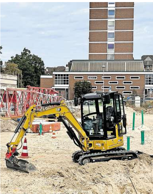
Altes Postgelände: Die vorbereitenden Arbeiten für den Neubau der Seniorenresidenz haben begonnen.
