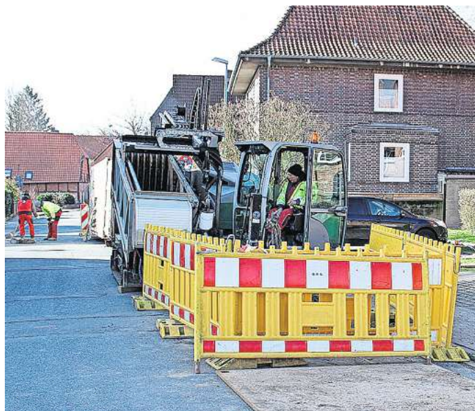
In Münstedt laufen die Bauarbeiten für die neue Druckrohrleitung, durch die das Abwasser in die Zentralkläranlage nach Gadenstedt geführt werden soll.
