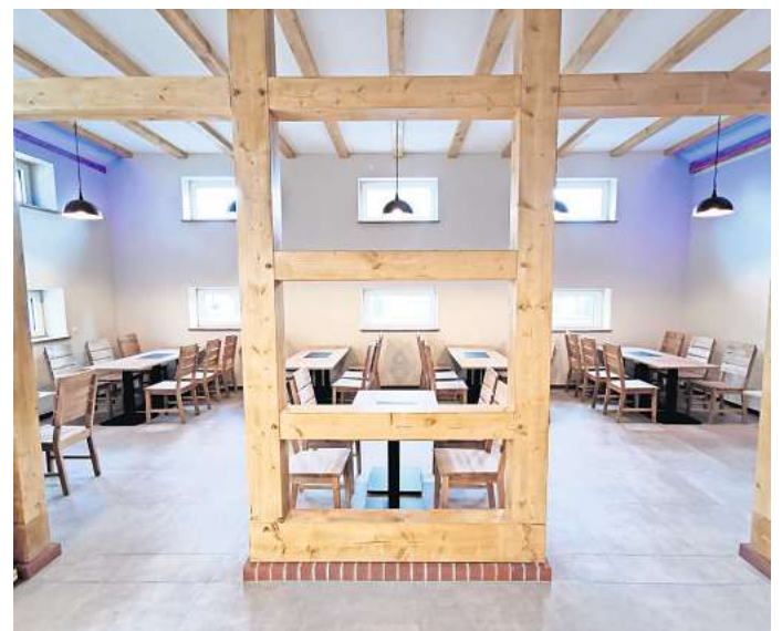
Das freigelegte Ständerfachwerk ist ein Blickfang.
