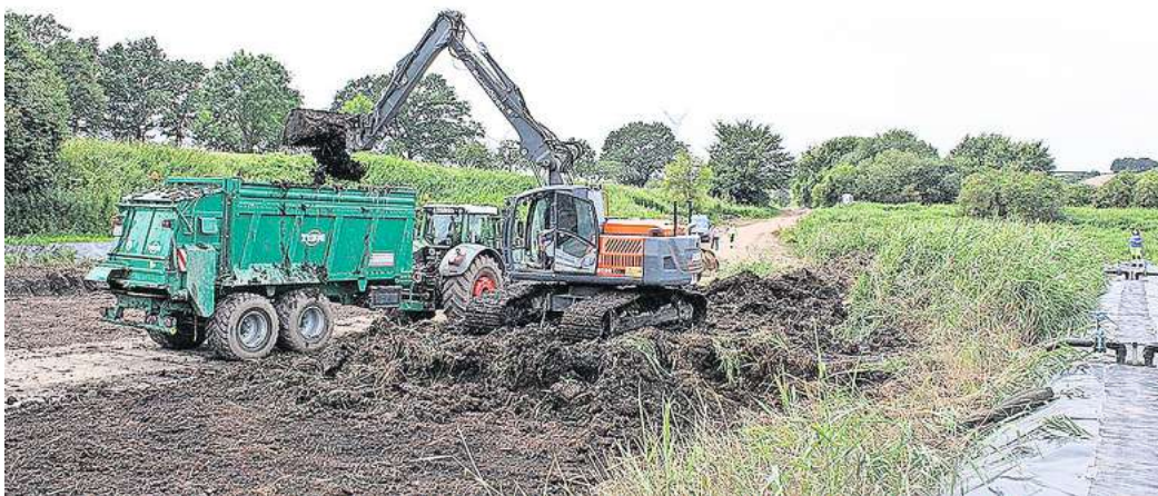
Ein Bild der letzten Beet-Räumung im August 2017 in Baddeckenstedt: Der Bagger verlädt die dunkle Klärschlamm-erde auf den Transporter.
