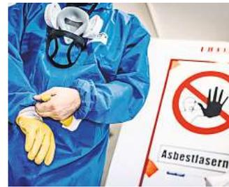
So sieht die richtige Asbest-Sanierung aus: Der Komplettschutz mit Overall, Atemschutzmaske, Handschuhe und Schutzbrille ist ein „Muss“ für die Bau-Gewerkschaft.
