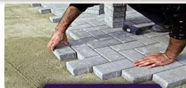
Pflasterverlegung
