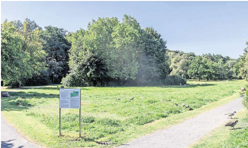
Die Bauarbeiten beginnen: In der Grünanlage Spackenkamp in Gebhardshagen wird eine Pumptrackanlage errichtet.
