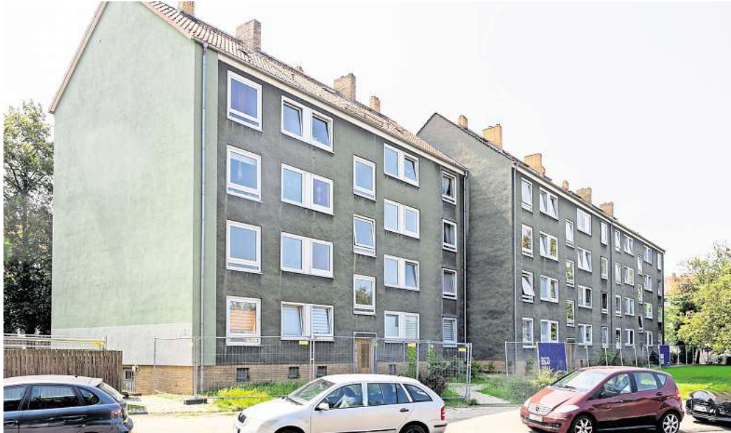
Wird energetisch und optisch auf Vordermann gebracht: Die TAG will den Wohnkomplex an der Suthwiesenstraße seriell modernisieren lassen.
