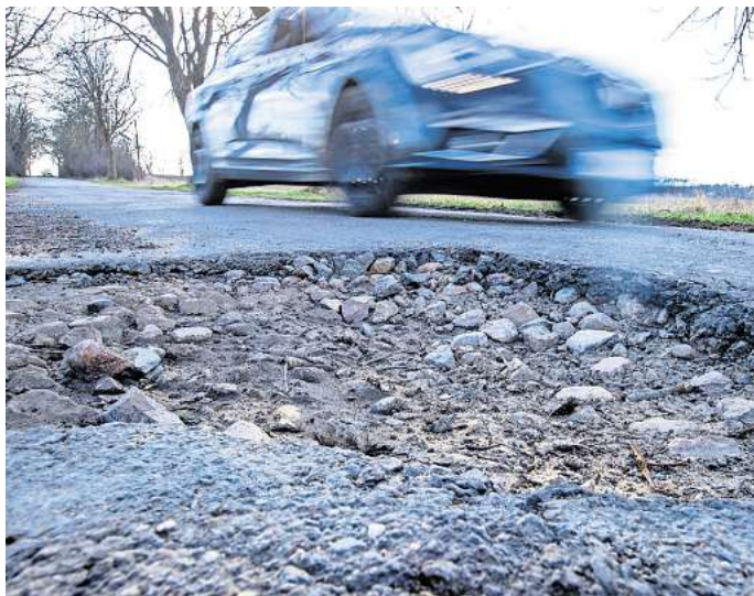
Wer mit hohem Tempo durch ein Schlagloch fährt, riskiert Schäden an Lenkung, Radaufhängung, Reifen und Felgen.
