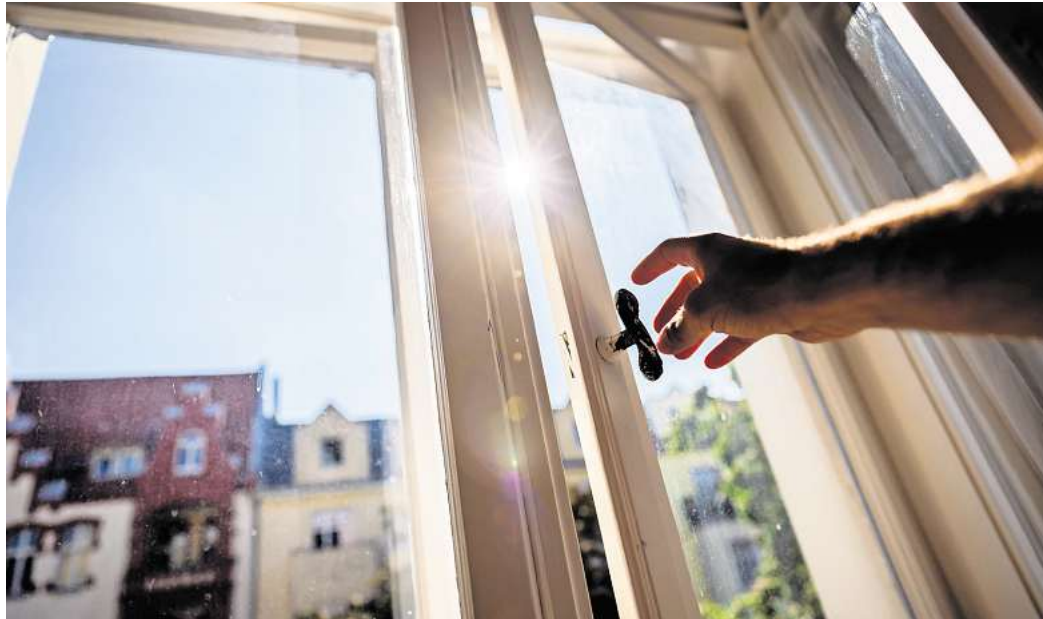
Längeres Lüften im Frühling: Die feuchtere Luft erfordert längere Lüftungszeiten, um Schimmelbildung vorzubeugen.
