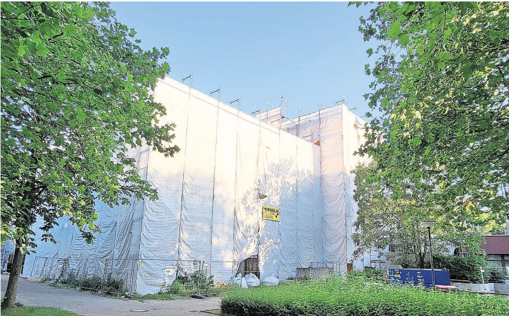
Komplett eingehüllt: Der Turm 0 des Gymnasiums am Fredenberg gehört zu den Großbaustellen in den Sommerferien. Foto: Stadt Salzgitter
