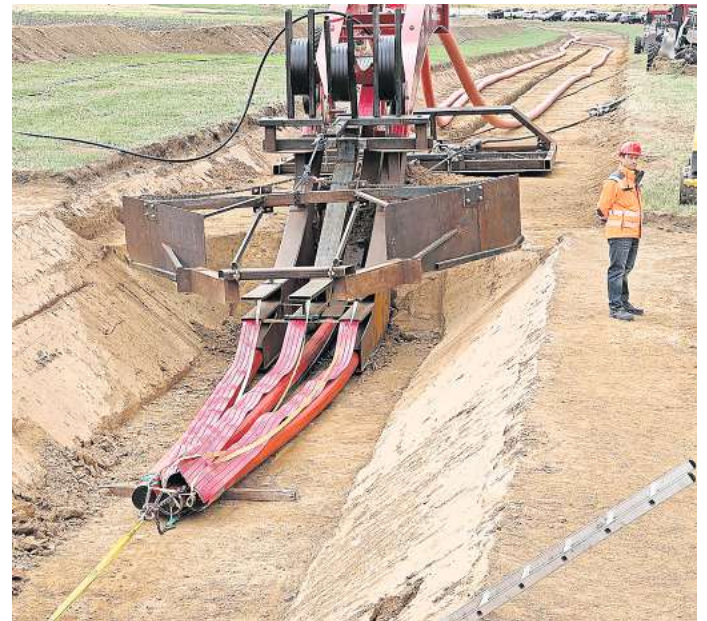
Arbeiten für die Energiewende: Die Firma Tennet verlegte auch in der Region Salzgitter mehrere Erdkabel, um den Strom vom Norden in den Süden leiten zu können. FOTO: RUDOLF KARLICEK
