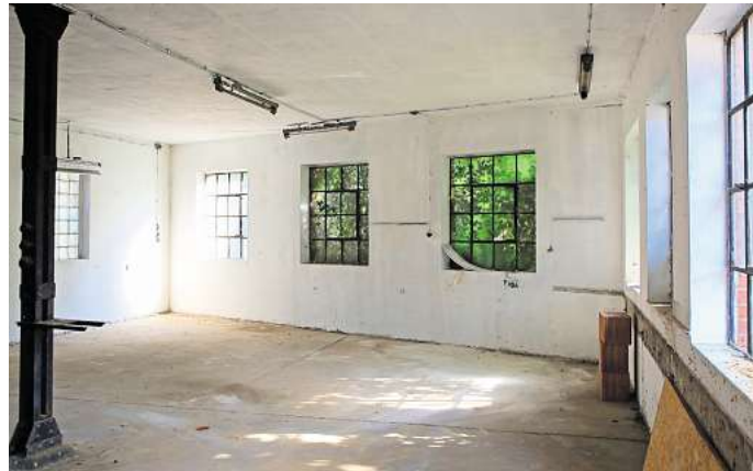
„Projekt Hauptstraße 7“: In der ehemaligen Werkstatt Schepelmann möchte die Gemeinde Meinersen einen Bürgertreff einrichten. FOTO: GERO GEREWITZ
