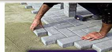
Pflasterverlegung
