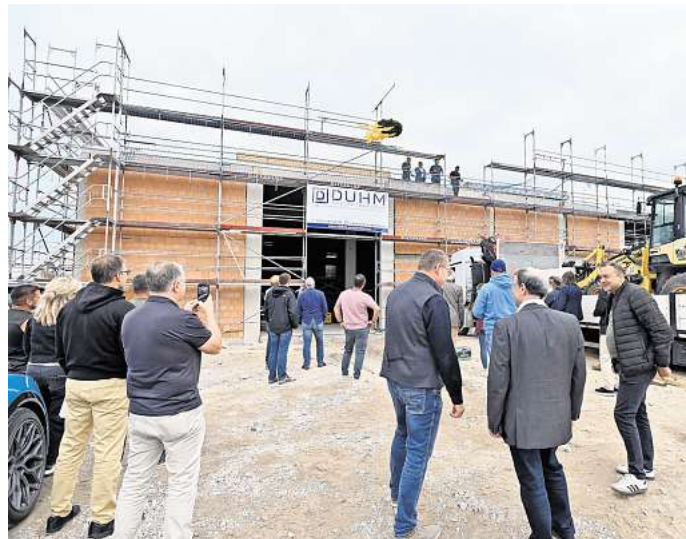
Meilenstein erreicht: Beim Neubau des Hillerter Netto-Marktes feierte man jetzt das Richtfest. Neueröffnung soll am 9. Dezember sein. FOTO: RON NIEBUHR
