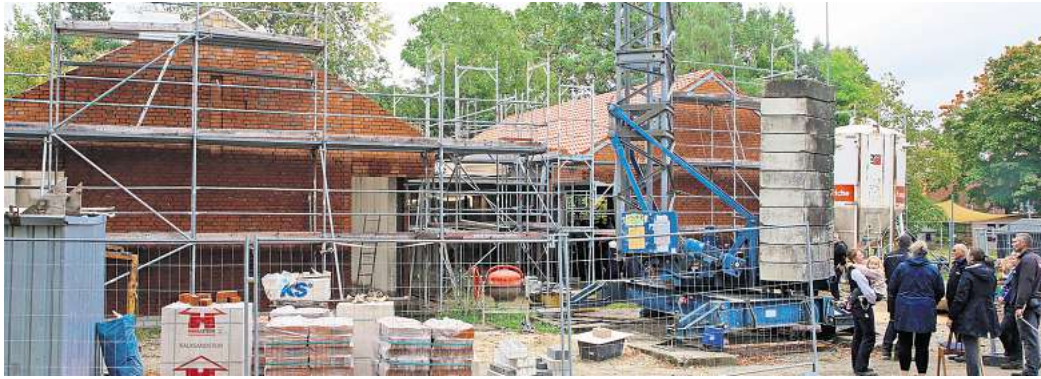
Beim „DoerpHus“ in Groß Oesingen wurde nun Richtfest gefeiert.
