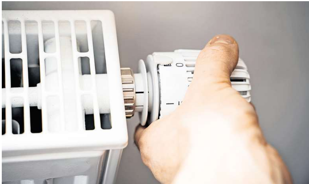
Viele Heizungen bleiben trotz sinkender Temperaturen noch aus
