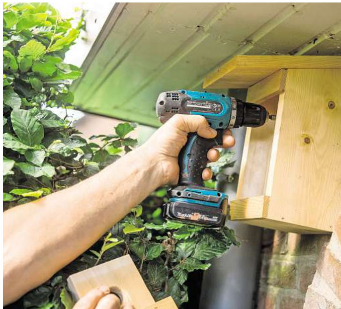
Regen? Kein Problem! Unter dem Dachvorsprung bleibt der Kasten trocken.
