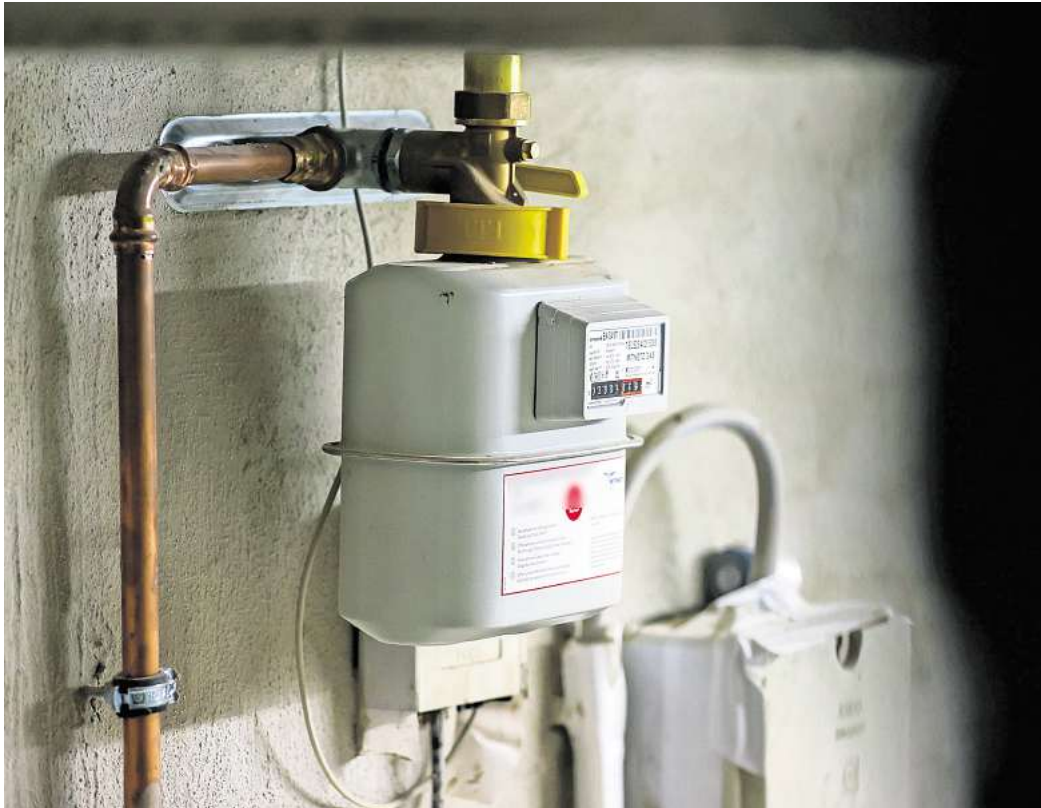
Eine Stilllegung oder ein Rückbau des Gasanschlusses kann unter Umständen enorme Kosten verursachen.
