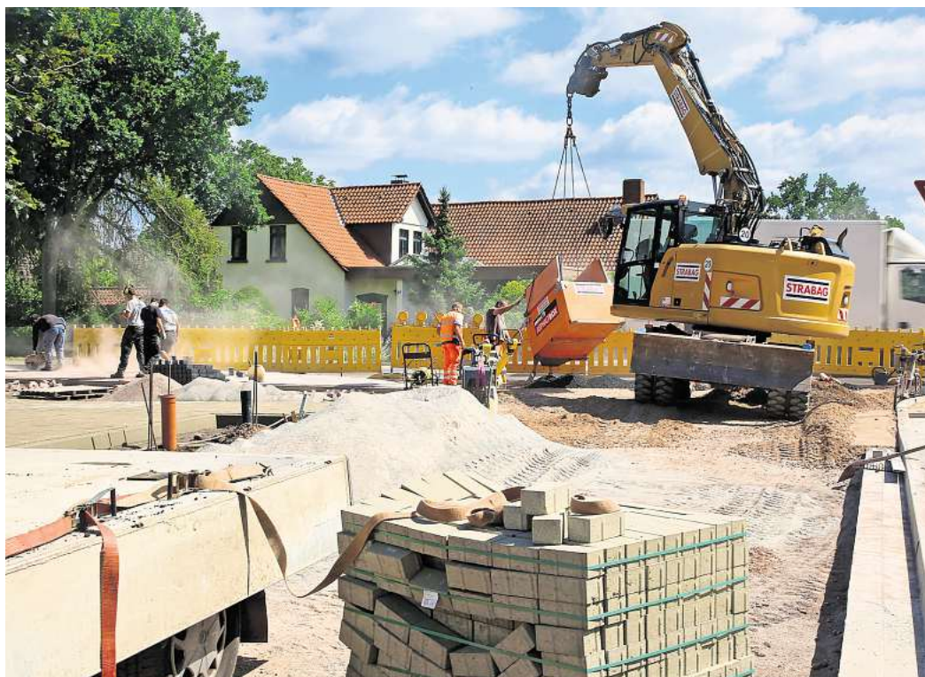
Bauarbeiten im Sonnenweg: Gossen und Borde liegen, jetzt geht es an die Nebenanlagen.
