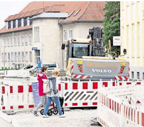
Noch dominieren Bagger und Baumaßnahme: Die große Umgestaltung der Hindenburgstraße läuft nach Plan. Nach Ende der Bauarbeiten ist dann endgültig Schluss mit Autoverkehr in dem Bereich. Foto: Sebastian Preuß
