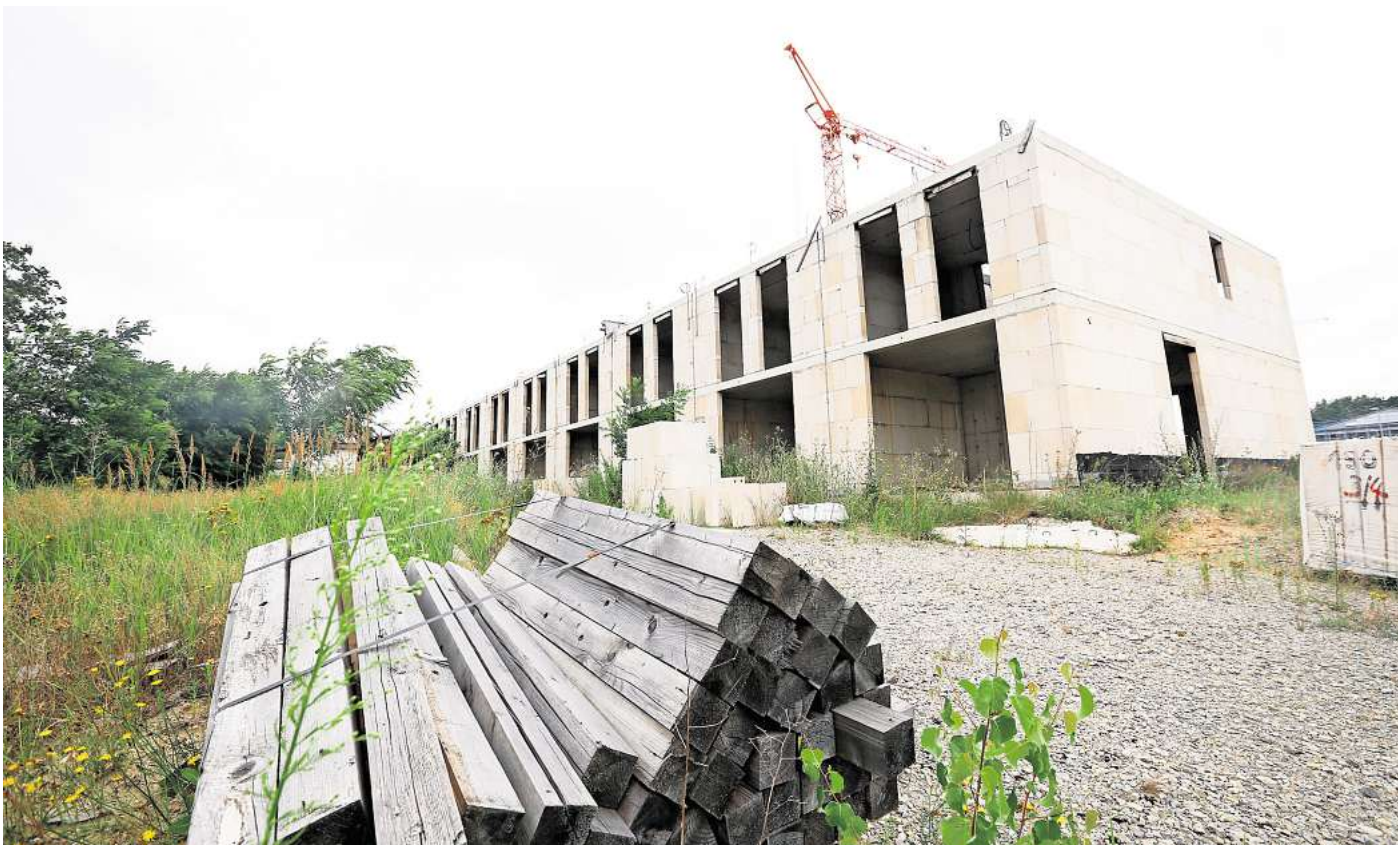
Rohbauruine im Gifhorer Baugebiet Hohes Feld: Die Insolvenzverwaltung ist in Verhandlungen mit einem interessierten Investor.
