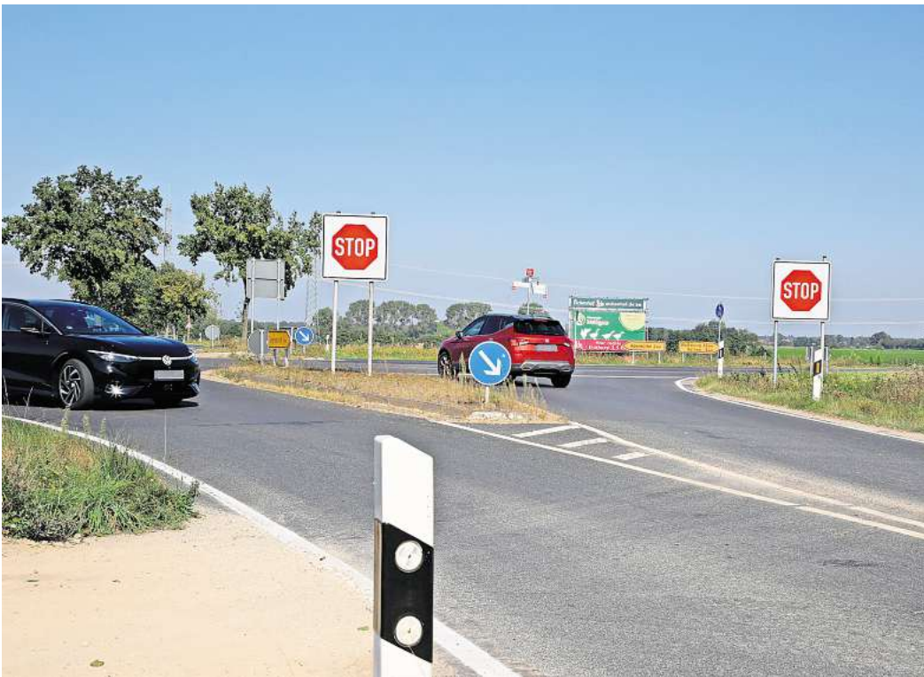
2027 soll es so weit sein: Das Land baut die Kreuzung der L321 bei Lagesbüttel zu einem Kreisel um. Foto: Gero Gerewitz
